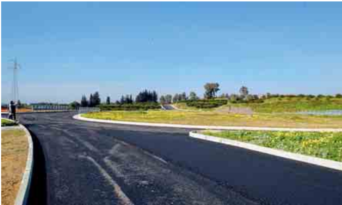
LA ROTATORIA DI COLLEGAMENTO DELL'ASSE ATTREZZATO CON IL COSTRUENDO OSPEDALE SAN MARCO A LIBRINO
